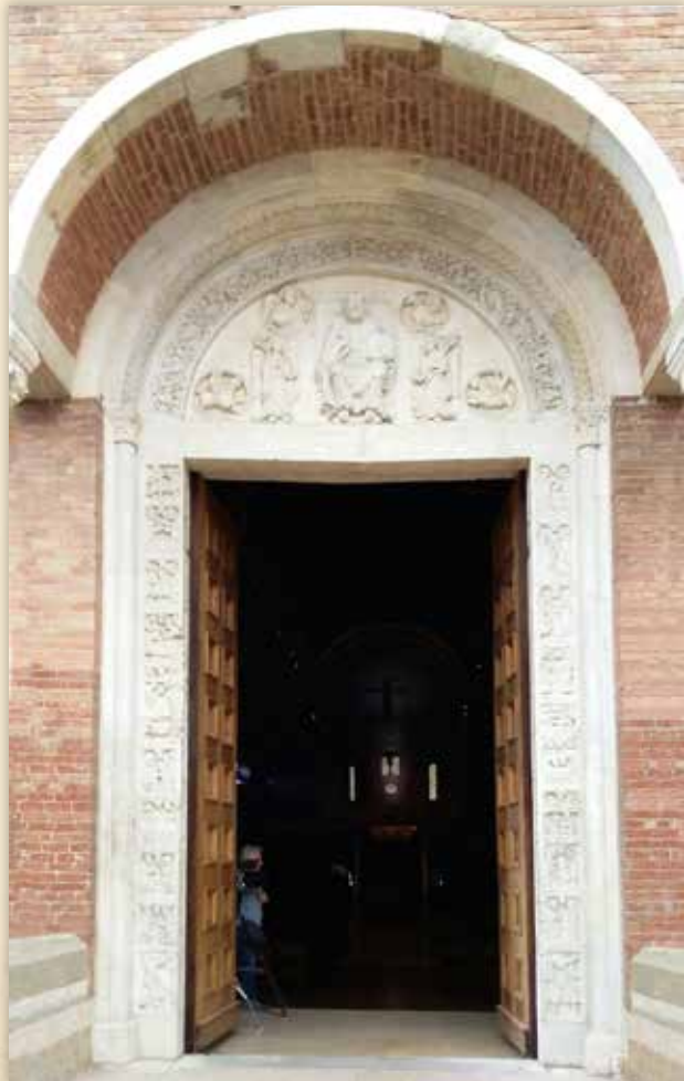
Das geöffnete Portal von Nonantola lädt alle zum Eintritt ein.
